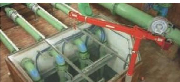
Carichi, strumenti o pompe possono essere sollevati e abbassati tramite il martinetto integrato.
